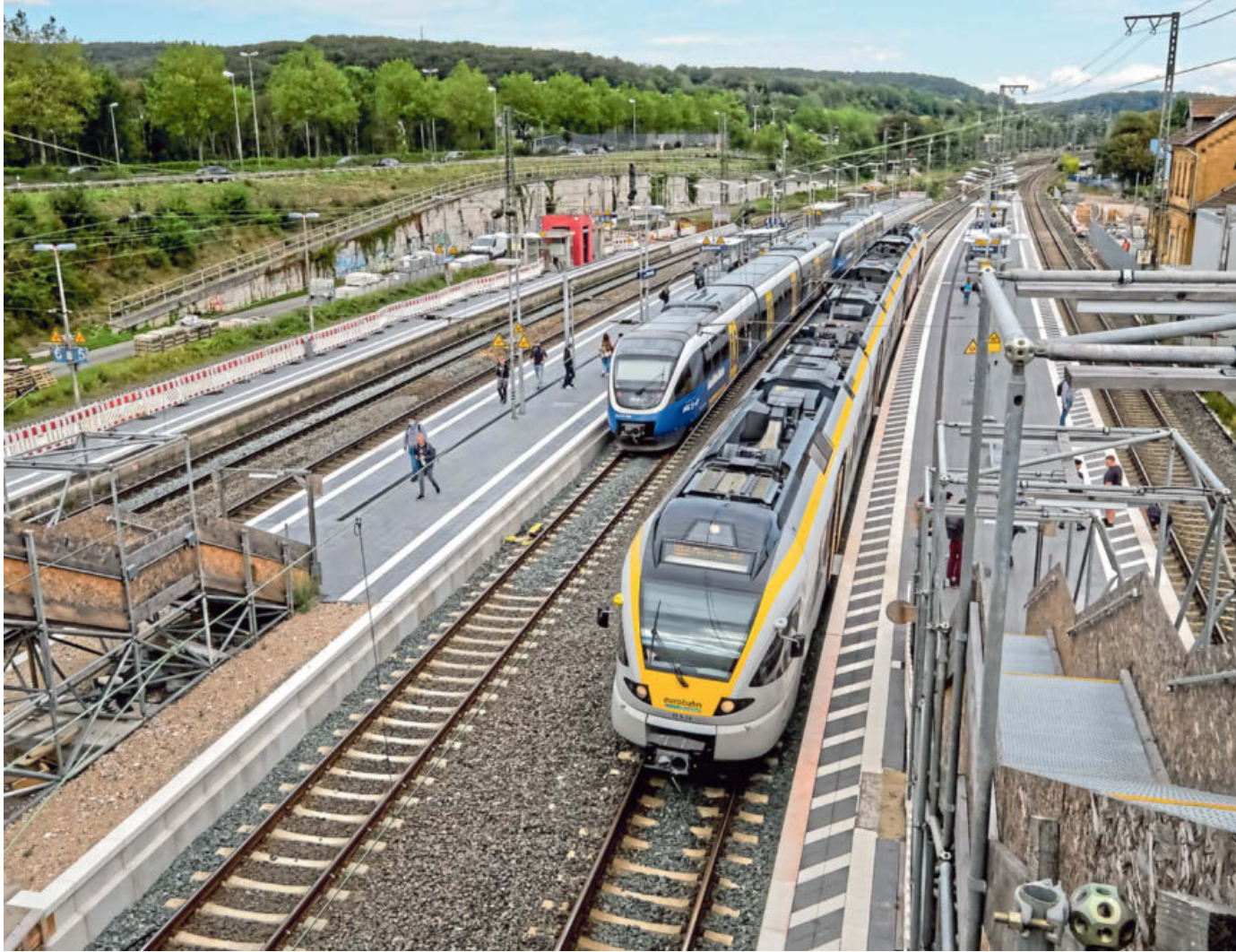
Die Modernisierungsarbeiten am Bahnhof Brackwede sind sichtbar fortgeschritten. Die Bahnsteige sind erhöht, teils verlängert und schon weitgehend neu ausgestattet. In der zweiten Jahreshälfte 2021 soll alles fertig sein.
