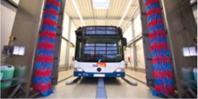
2013 - Erste Fahrt durch die neue Buswaschanlage.
