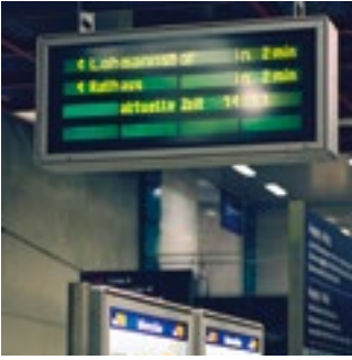
1997 – Inbetriebnahme der Dynamischen Fahrgastinformation (DFI).
