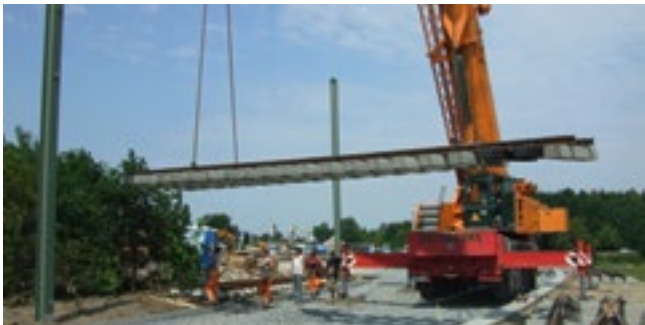
2008 – Arbeiten am Umbau des Gleisnetzes für neue, größere StadtBahn-Wagen.
