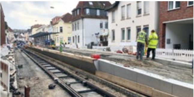
2019 - Arbeiten für den barrierefreien Ausbau der Strecke nach Stieghorst.
