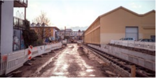
2018 – Baubeginn für den neuen Hochbahnsteig im Dürkopp-Viertel.
