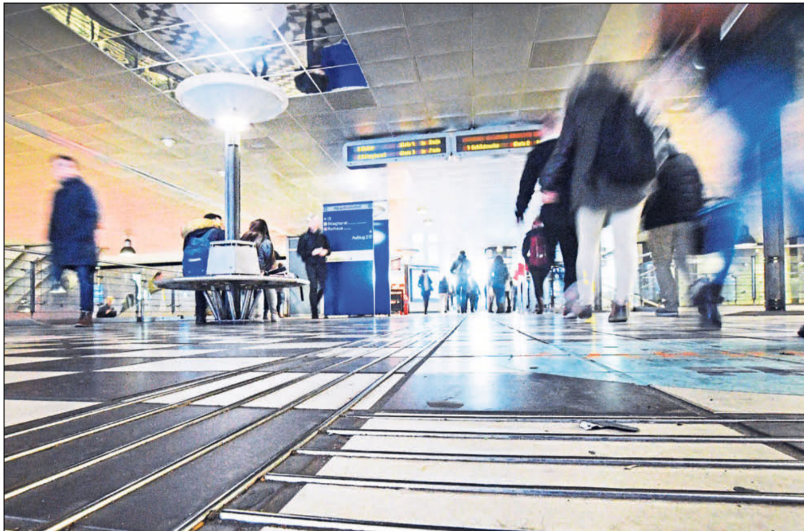
Wer blind ist, findet sich an der Stadtbahnhaltestelle am Bahnhof dank der Leitlinien gut zurecht. Menschen mit stark eingeschränk-
