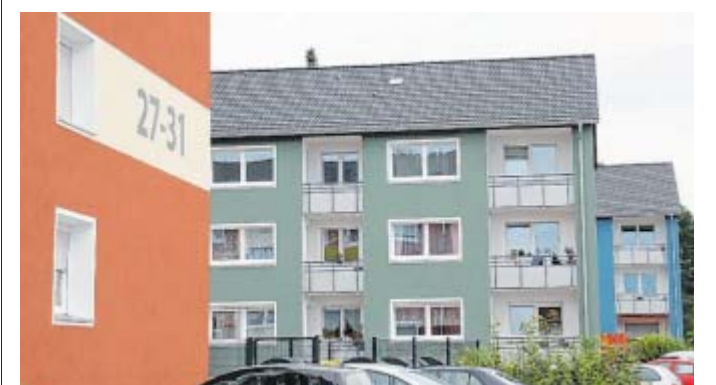
Sennestadtfarben: Am Stadion sind die Renovierungsarbeiten von Vonovia weitestgehend abgeschlossen. FOTO: SILKE KRÖGER
